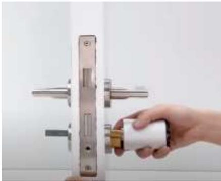
Schieben Sie nun den X4Z Zylinder von vorne in das Steckschloss und befestigen Sie diesen mit der vorhandenen Schraube. Fixieren Sie nun wieder den hinteren Kauf, so dass dieser so nah wie möglich mit der Innenseite der Türe abschließt.
